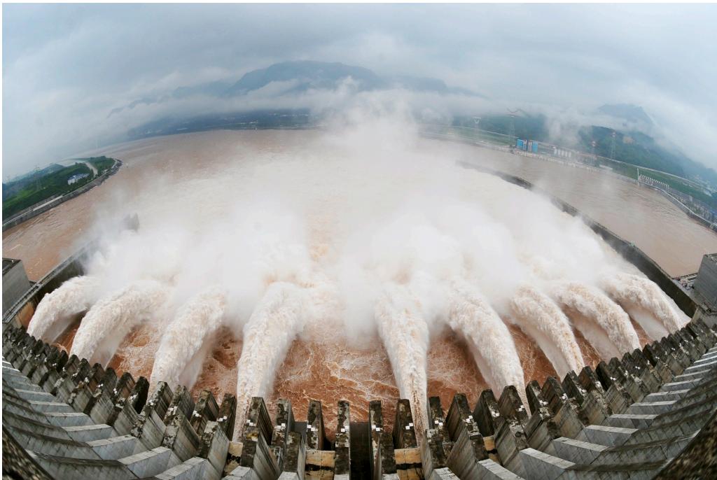
Figura 2 La presa de 3 garganta, Fuente: elperiodicodelaenergia, https://elperiodicodelaenergia.com/la-central-hidroelectrica-china-de-tres-gargantas-bate-el-record-mundial-de-generacion-electrica-anual-al-alcanzar-los-1118-twh/
