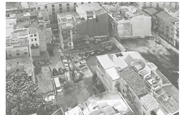
Vista aérea medianeras Este
