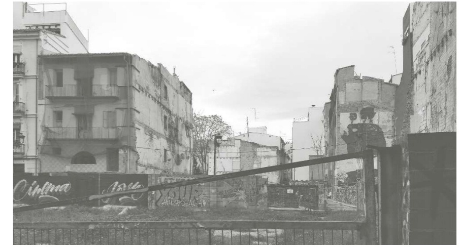
1.- Vista Norte desde calle del Conde Montornés
