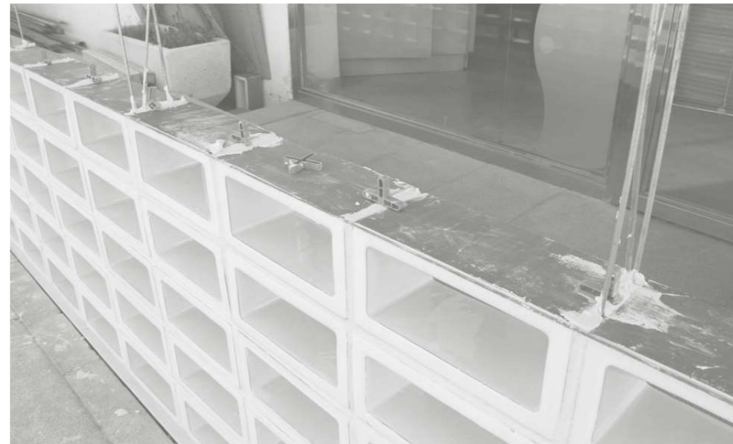
Ejemplo ejecución de armado vertical de celosía
