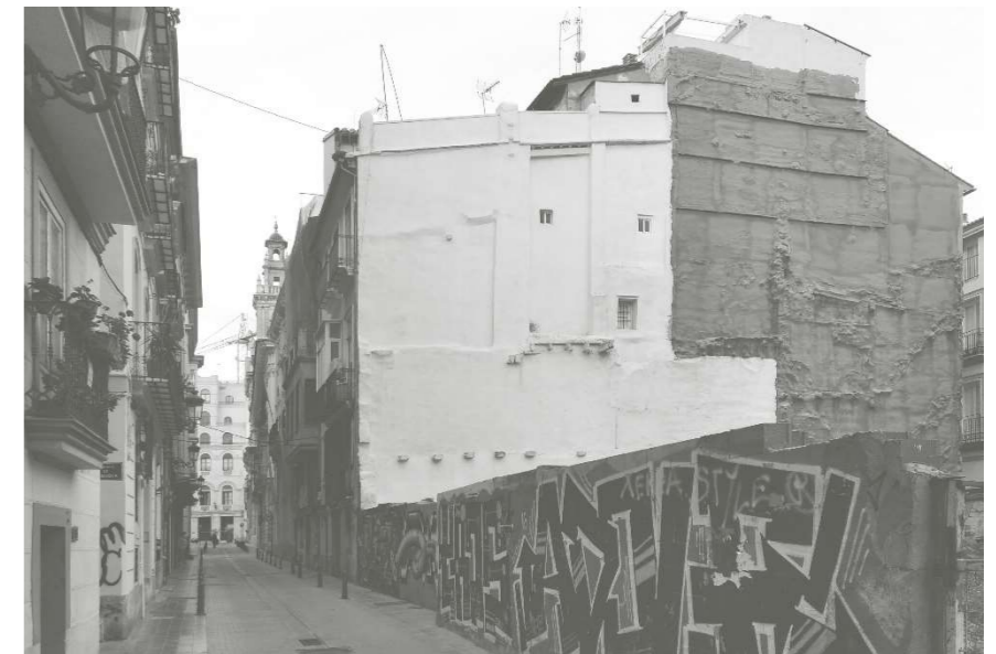
8.- Vista Este desde calle del Conde Montornés
