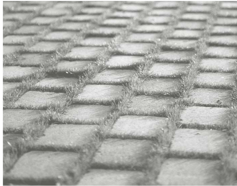
Pavimento adoquín con junta verde
