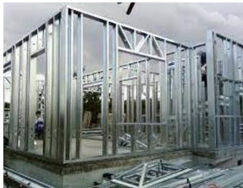
(Figura 21. Estructura metálica modular)
