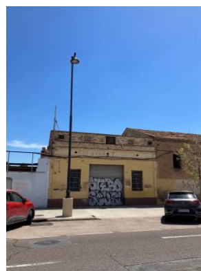
Fig. 12: Imagen de un edificio abandonado.
