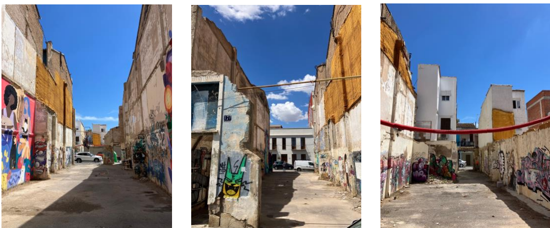
Fig. 16: Pasajes peatonales generados por la demolición parcial de edificios.
