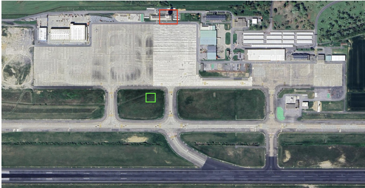
Figura 31: Emplazamiento torre convencional existente (rojo) y torre remota (verde) en el Aeropuerto de Vitoria
