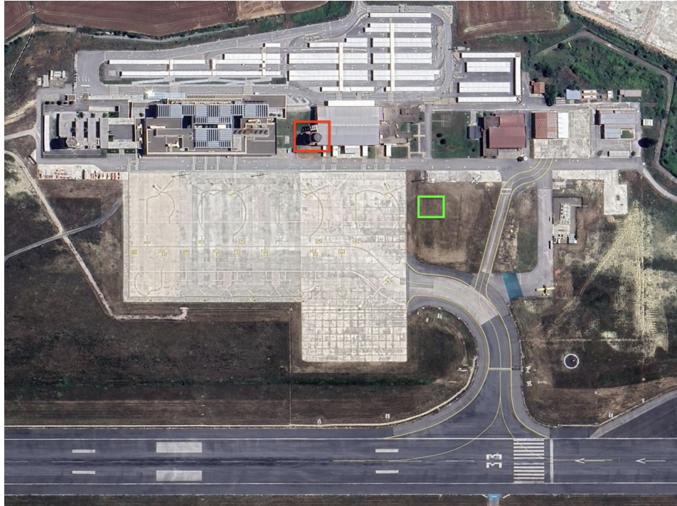
Figura 39: Emplazamiento torre convencional existente (rojo) y torre remota (verde) en el Aeropuerto de Pamplona
