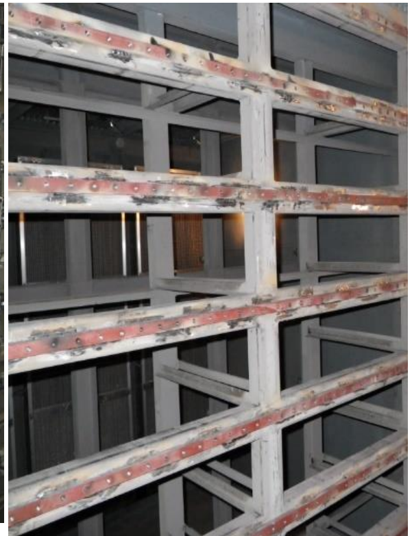
Ilustración 6 Racks sin las bandejas
