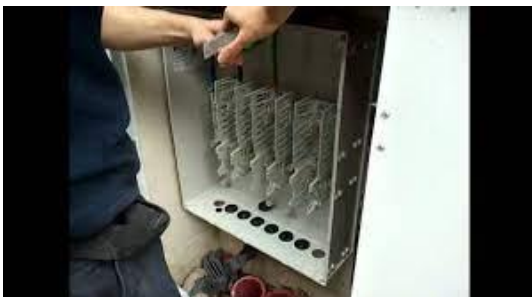
Ilustración 38: Desmontaje de Cajas de conexión, protección y control
