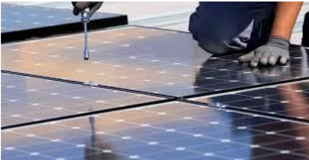
Ilustración 65:Mantenimiento de la estructura
