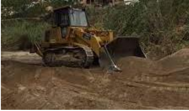
Ilustración 35: Tierras y pétreos de la excavación
