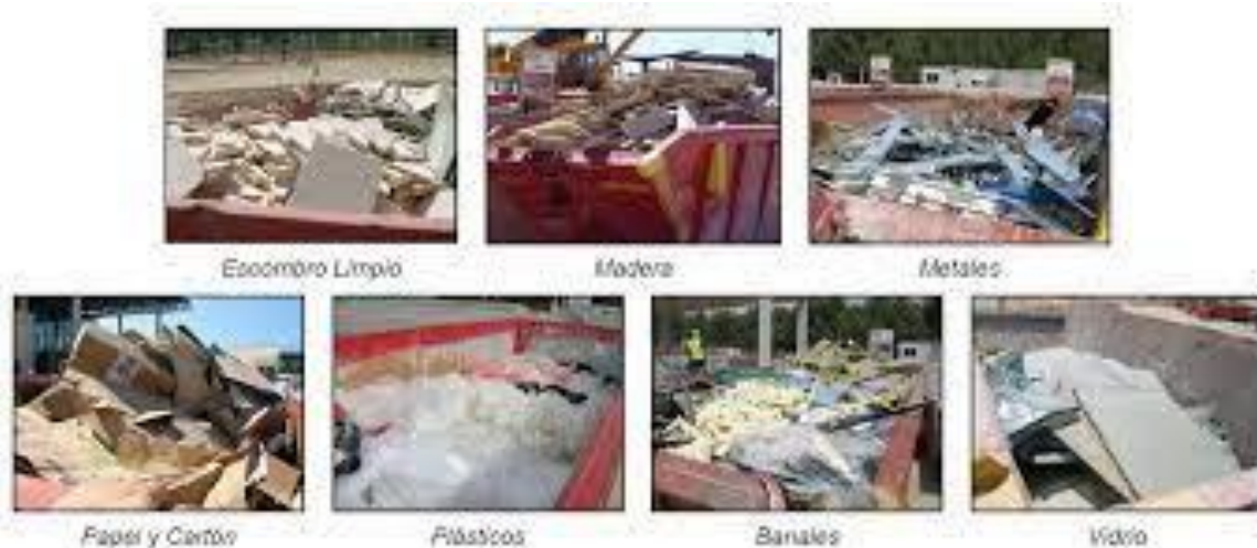
Ilustración 36: Residuos de naturaleza no pétreo resultantes de la ejecución de la obra
