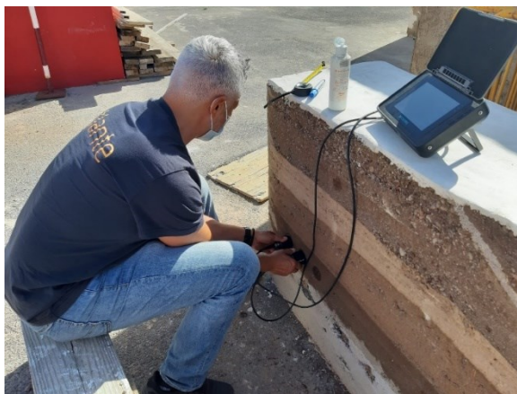
Fig.125: Ensayo no destructivo al tapial
