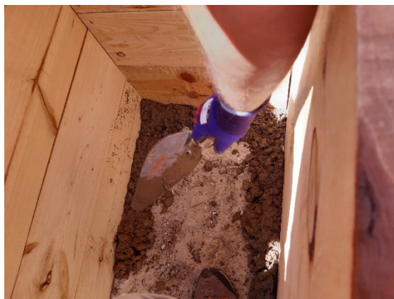
Fig.118: Ejecución del calicostrado (paso3)
