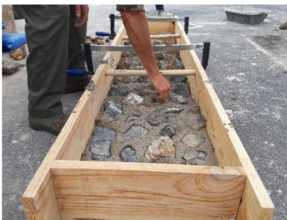
Fig.105: Ejecución del zócalo con hormigón blanco ciclópeo
