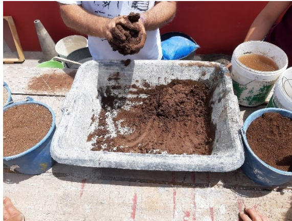
Fig.111: Amasado de la tierra de El Tornero (paso1)
