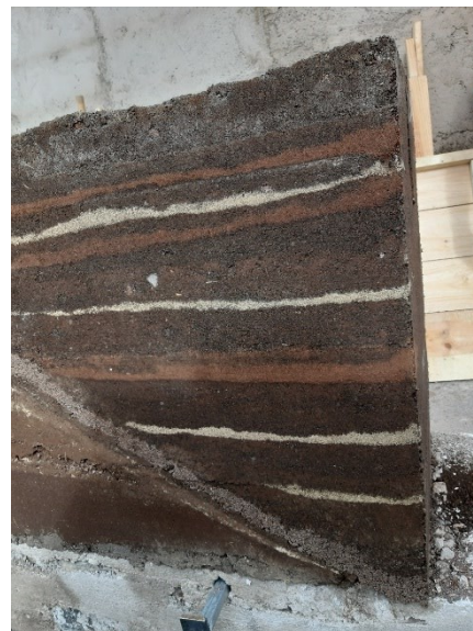
Fig.123: Detalle de tapial
