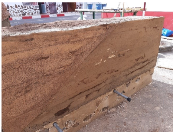
Fig.121: Zona del tapial recubierta con calicostrado
