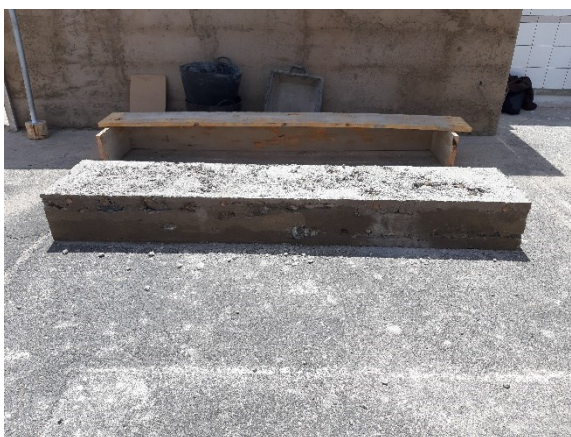
Fig.106: Zócalo desencofrado
