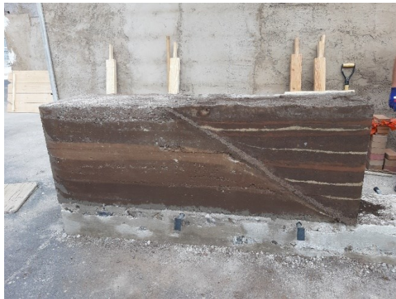
Fig.120: Tapial recién desencofrado
