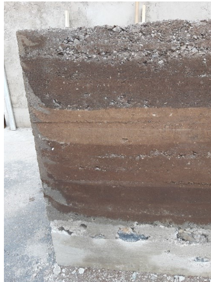
Fig.122: Detalle de tapial
