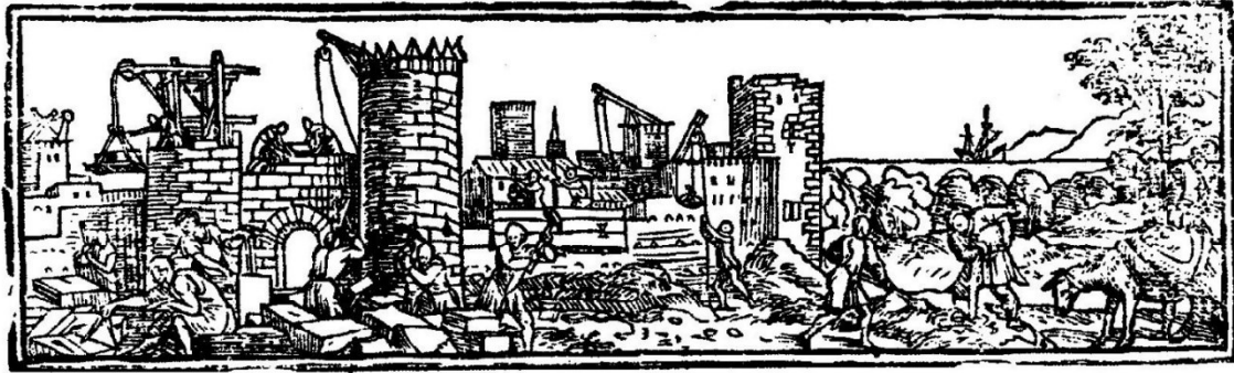
Fig.24: Grabado en el que se representa la construcción de la muralla de Valencia en el año 1546. Del libro 'Fiesta y urbanismo. Valencia en los siglos XVI y XVII'. Desirée Juliana
