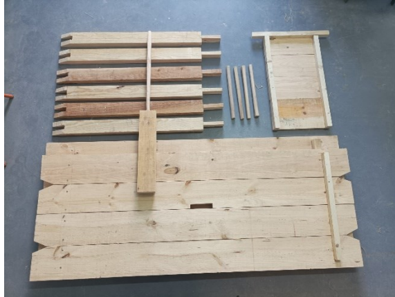
Fig.108: Las piezas del encofrado
