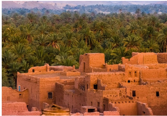
Fig.4: En el Valle del Draa, Marruecos existen ciudades fortificadas construidas con tierra en el siglo XVIII
