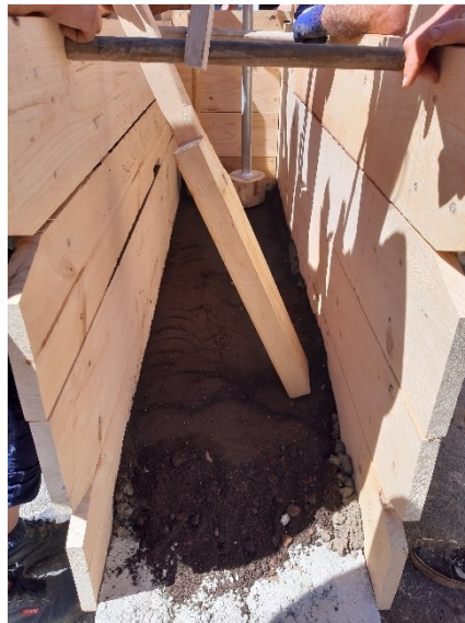
Fig.117: Apisonado de borde (paso2)
