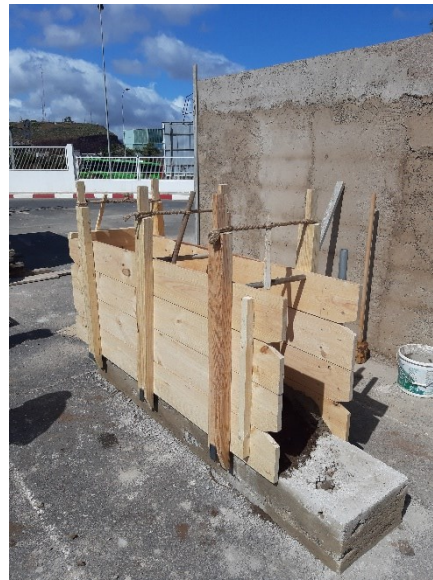
Fig.109: Encofrado listo para ejecutar el tapial
