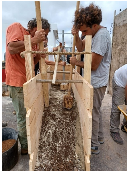
Fig.119: Apisonado de tierra con capa de cal en unión de dos tipos de tierras (paso 4)
