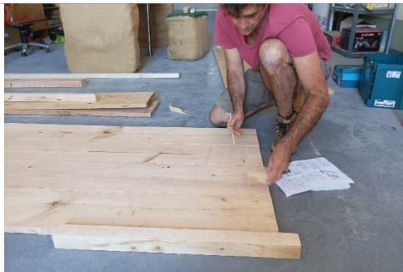
Fig.107: El autor de este TFG durante los trabajos de ejecución del encofrado en el almacén de La Isla Sostenible
