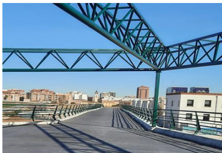
Figura 30. Ejemplo de pasarela construida en Valencia con hormigón Vertua, por CEMEX.
