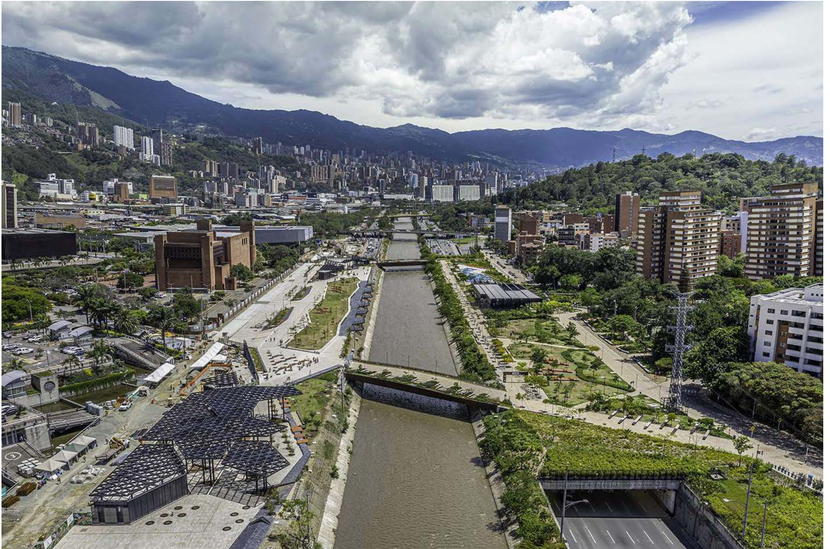
Img. 10 Sobreuelo, Obra Parques del Río Medellín, Antioquia, 2016.
