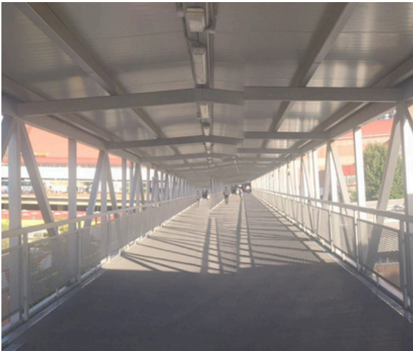
Imagen 8. Puente hacia estación Chamartin
