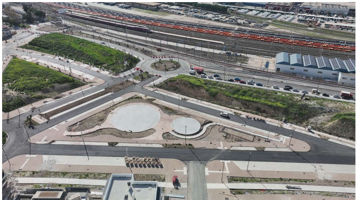
Imagen 16. Entorno zona de actuación Fuente: CAI Consultores de Ingeniería
