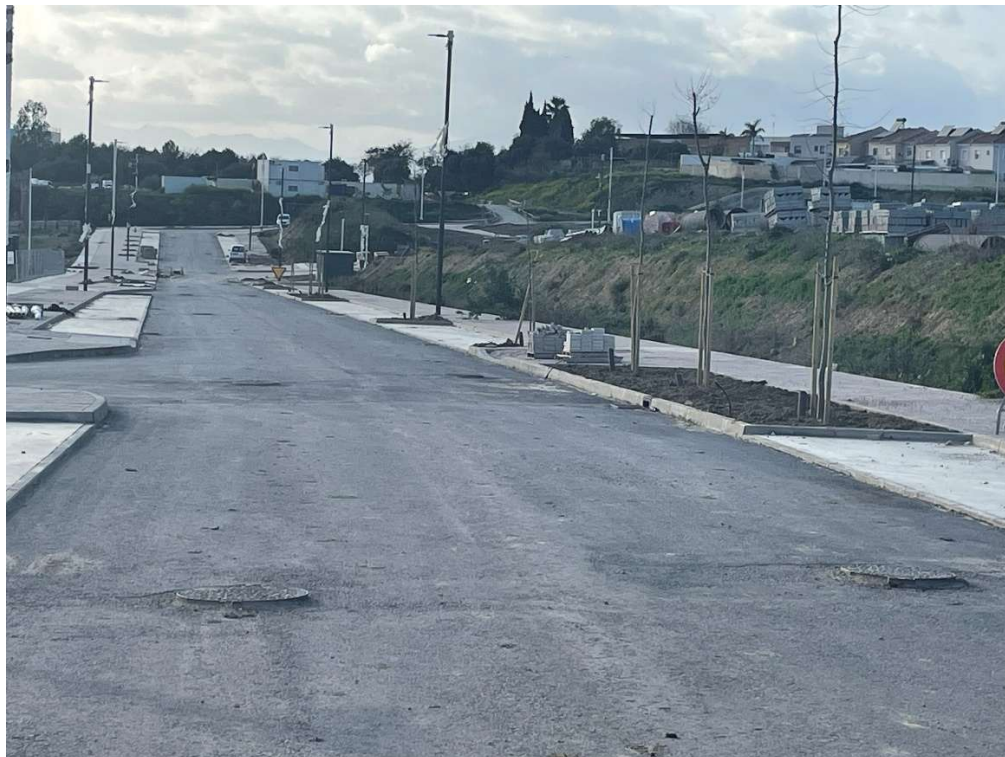
Imagen 24. Infraestructura de viario. Lateral derecho zona para huertos urbanos. Fuente: Autor.
