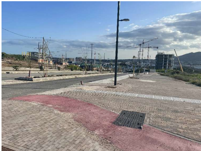
Imagen 27. Interacción carril bici con zona peatonal. Fuente: Autor
