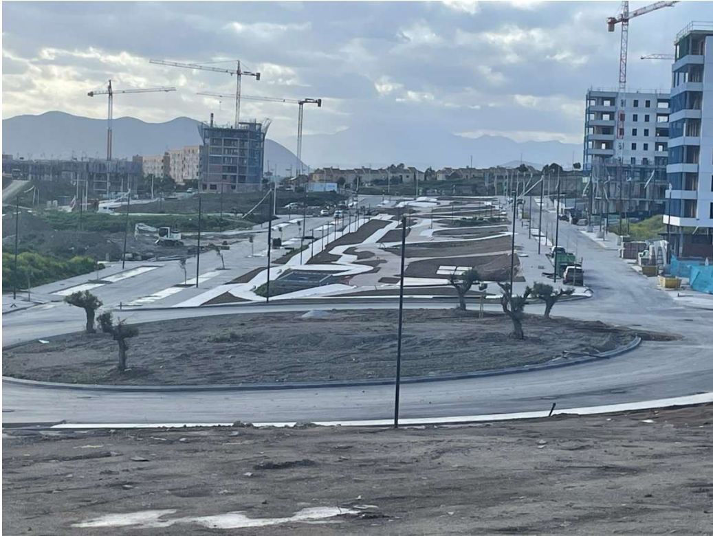
Imagen 17. Entorno zona de actuación Fuente: Autor
