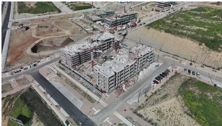
Imagen 25. Construcción de viviendas. Fuente: CAI Consultores de ingeniería SL.
