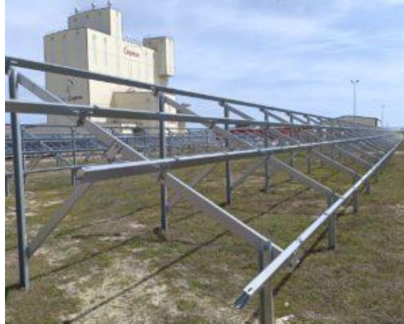
Ilustración 11. Estructura incada para la instalación de módulos solares. Tomado de [13]
