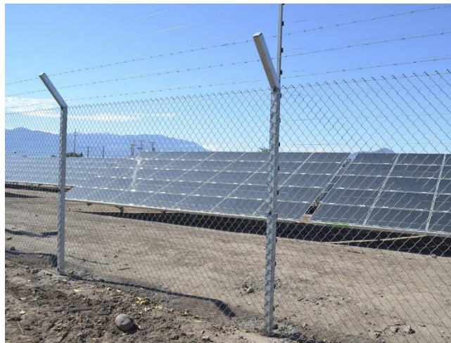
Ilustración 75. Cerramiento tipo en malla. Tomado de [91]
