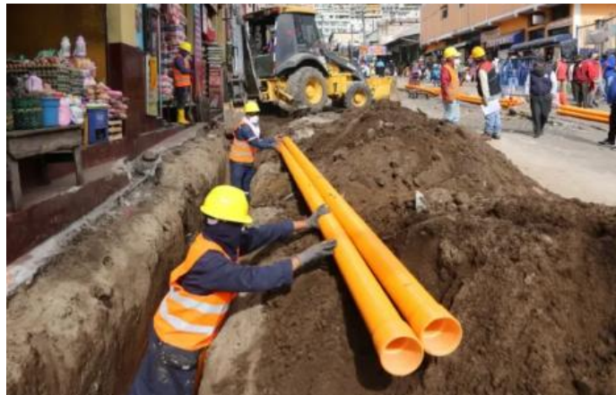
Figura 58. Proyecto de soterramiento de cables en Quito-Ecuador
