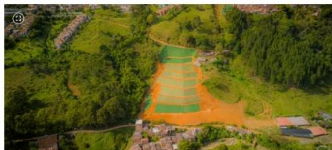
Las obras de estabilización de los terrenos afectados por la temporada invernal en Medellín avanzan en un 65 por ciento. Foto: Alcaldía de Medellín.
