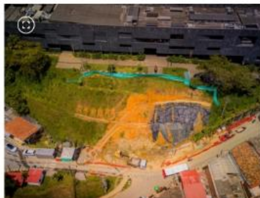
Las intervenciones en los terrenos afectados se caracterizan por la estabilización del terreno. FOTO: ALCALDÍA DE MEDELLÍN.
