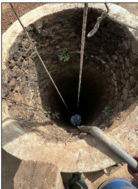
Figura 9 Pozo raso manual en una de las concesiones de Itato.
