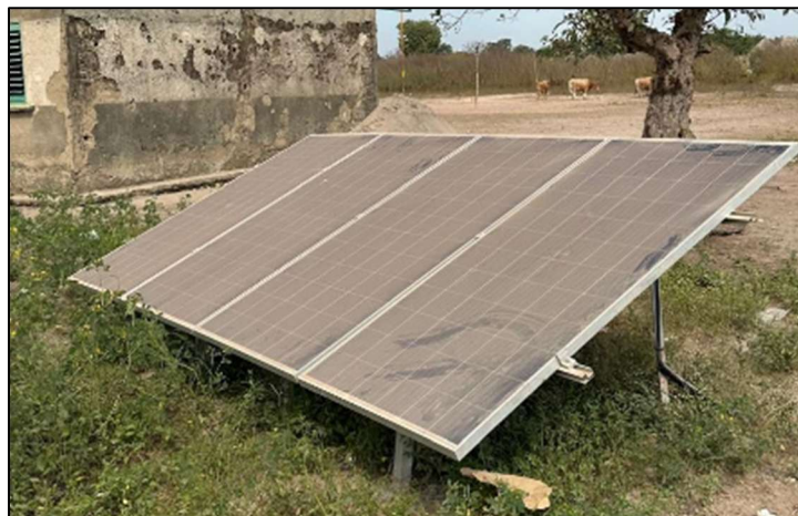
Figura 11 Instalación fotovoltaica para bombeo. Itato
