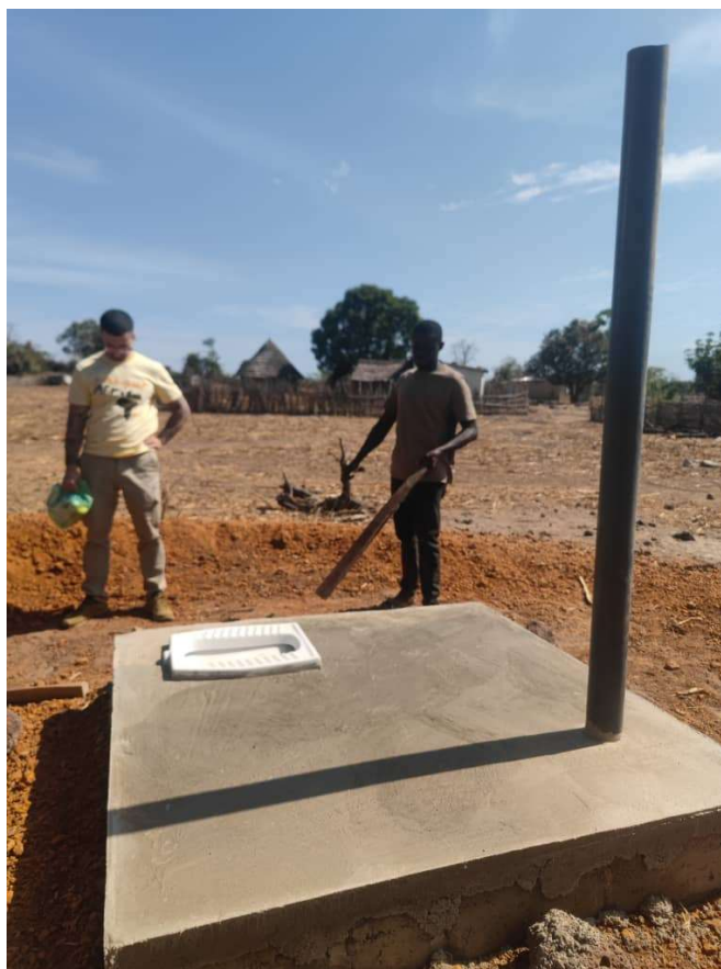
Figura 13 Acabado superior de letrina tipo construida por Yakaar Africa. Itato.
