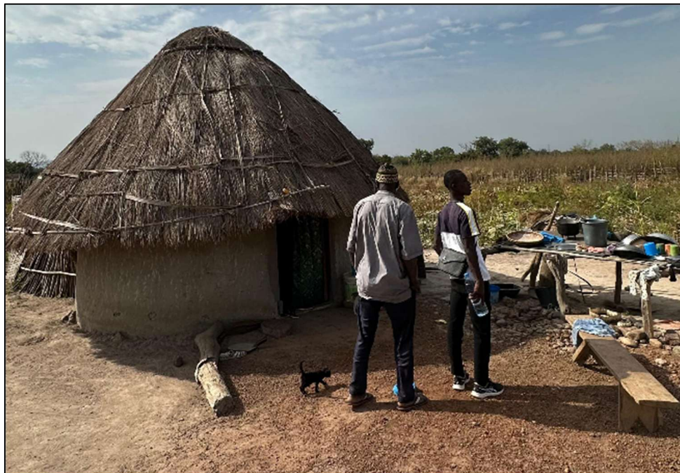
Figura 4 Vivienda de construcción estándar en la región de Kedougou.
