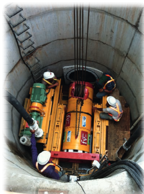
Figura 107. Pozo de ataque. Pipe Jacking Associate. 2017.
