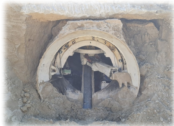
Figura 13. Escudo abierto. Brazo con cazo. Fuente propia.2021.
