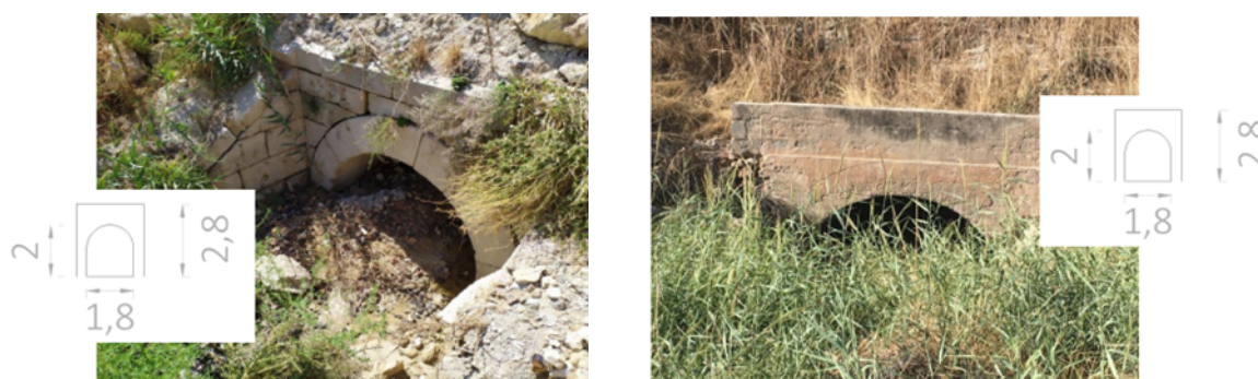
Figura 145. ODTs tributarias a colmatadas. Fuente propia.
