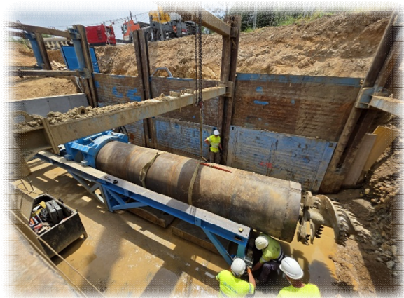
Figura 16. Auger Head. Fuente propia.2025.
