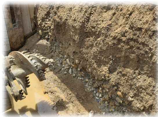
Figura 15. Cabezal y frente de ataque. Fuente propia.2025.
