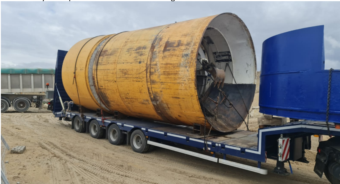
Figura 155. Escudo abierto con útil de corte mediante cazo empleado en el caso de estudio. Fuente propia.
