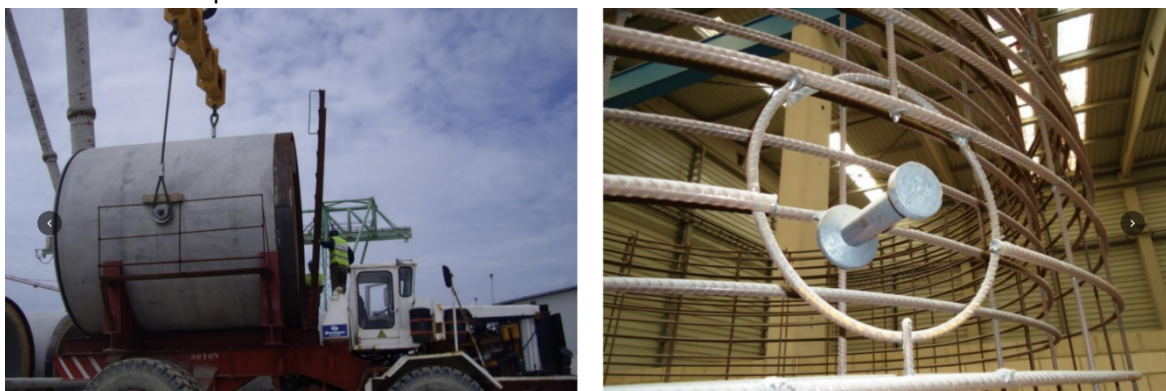
Figura 90. XI Ed. Izaje de tubos de hormigón y puntos de izaje. XI Ed. Curso Postgrado 2025. Especialista en tecnologías sin zanja. IBSTT.
