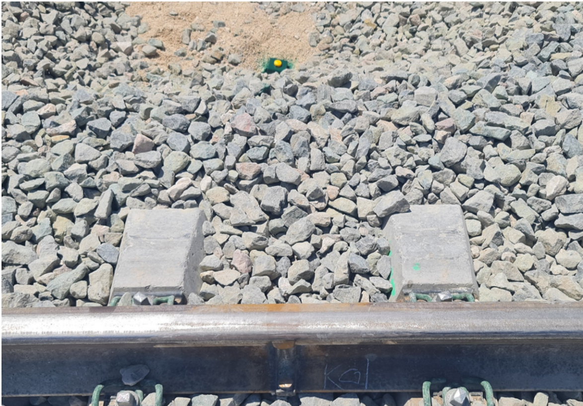
Figura 158. Hitofeno en la cabeza del talud para control de asientos mediante topografía clásica. Fuente propia.
