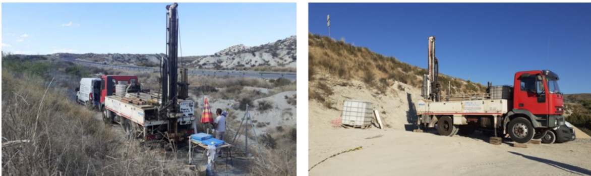
Figura 148. Ejecución de sondeos en el ámbito de actuación. Fuente propia.
