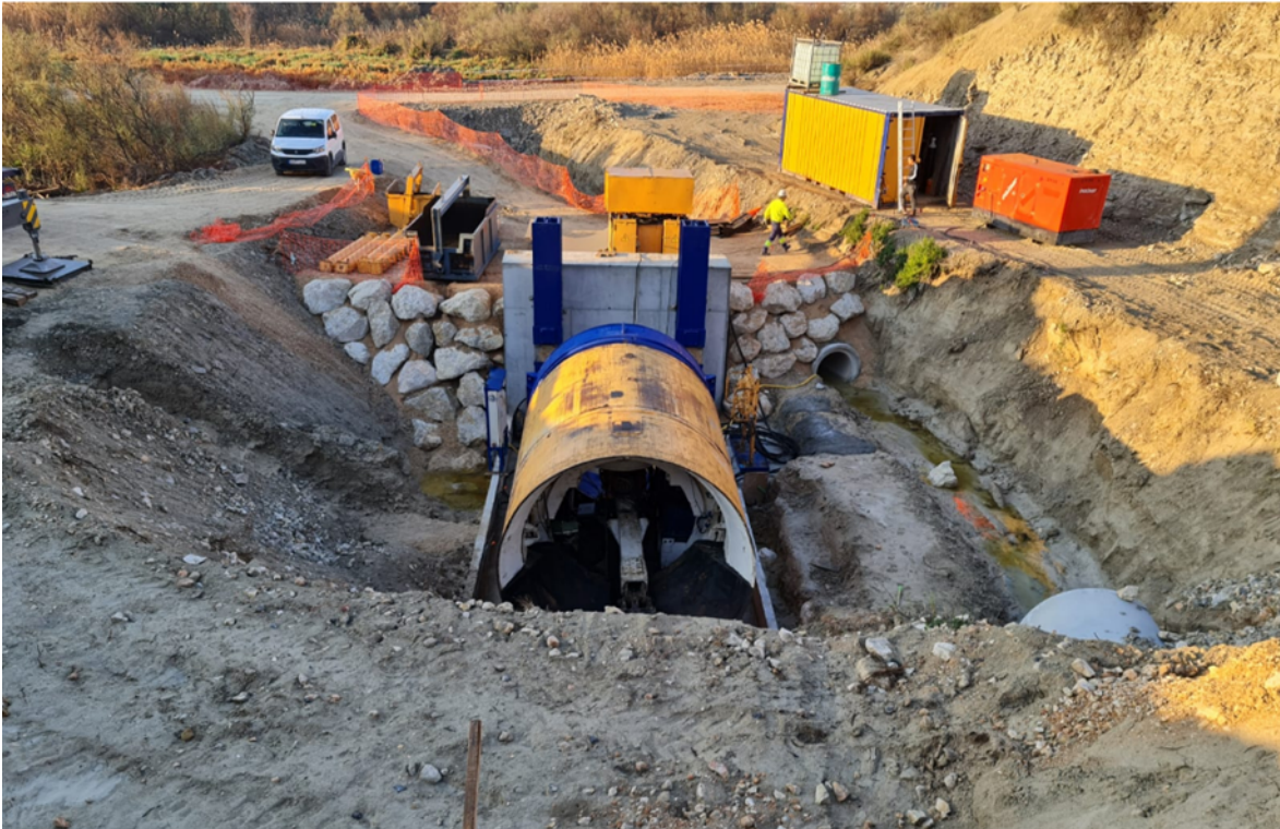
Figura 156. Muro de empuje y estación no compacta utilizada en el caso de estudio. Fuente propia.
