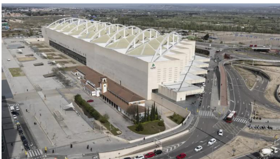
Figura 3-49. Estación de Delicias, Zaragoza. (Fuente: Guillermo Maestre. Heraldo de Aragón)
