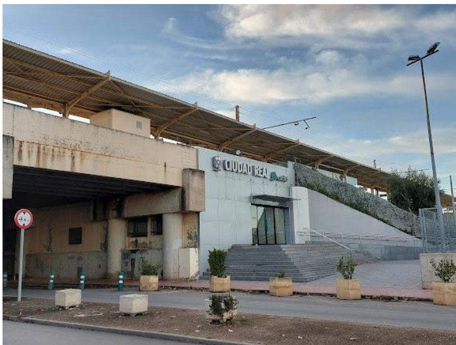
Figura 3-43: Estación de Ciudad Real. (Fuente: Google Images).
