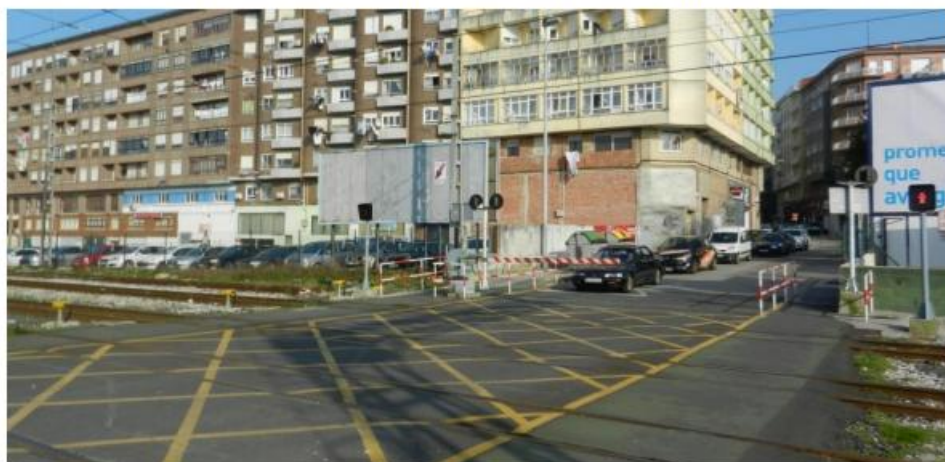
Fotografía 8. Paso a nivel del ferrocarril de ADIF Red de Ancho Métrico en Pablo Garnica
