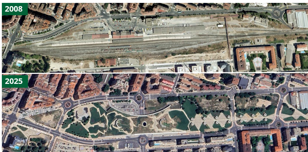
Figura 3-38. Transformación en el centro de la ciudad de Logroño. (Fuente: Adif)
