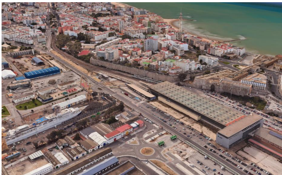
Figura 3-54: Imagen de la estación de Adif en Cádiz, con salida en superficie y boca del túnel del soterramiento. (Fuente: Captura de Google-earth)
