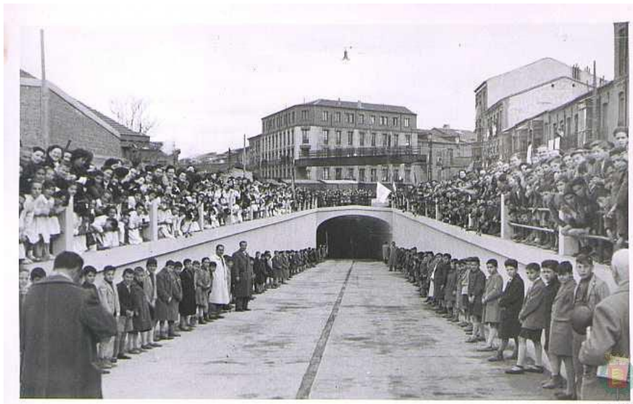
Figura 3-7. Inauguración del Paso Inferior de Labradores, Valladolid (1952). (Fuente: Diario de Valladolid)
