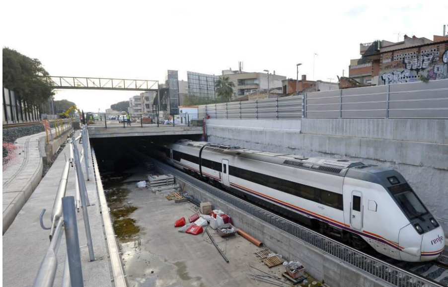
Figura 3-57: Soterramiento en Murcia. (Fuente: Adif)
