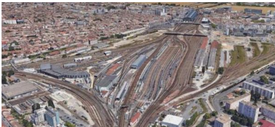
Figura 3-70: Ámbito ferroviario cerca de la estación de Burdeos (Francia) (Fuente: Google Earth)
