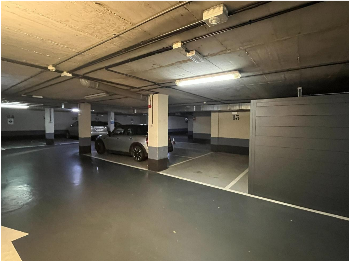
Ilustración 15 - Interior Aparcamiento María de Molina
