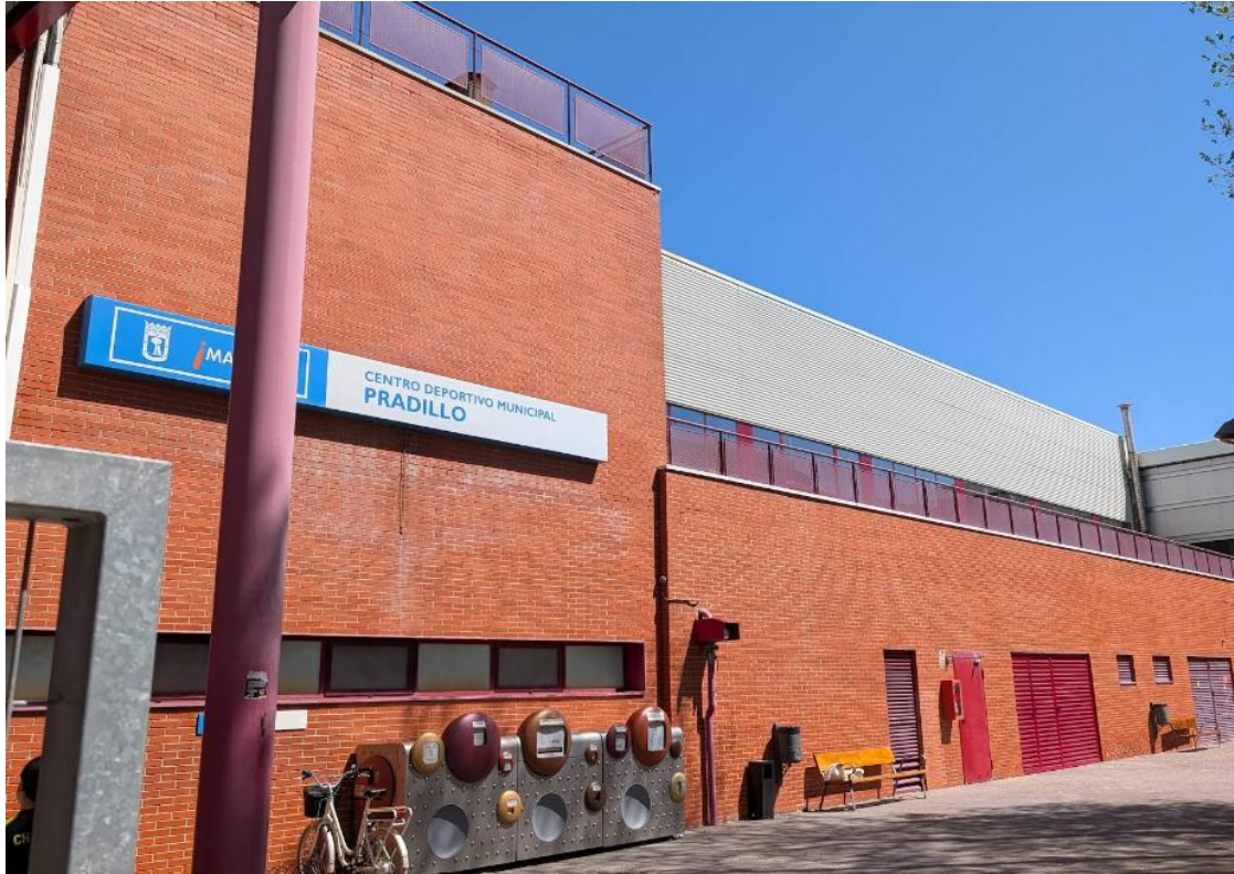
Ilustración 47 - Espacio amplio en el acceso a Centro Deportivo Municipal Pradillo
