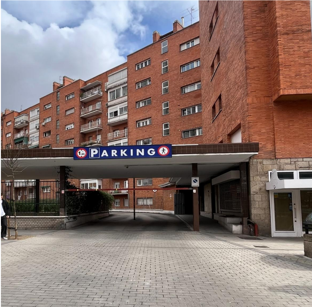
Ilustración 21 - Acceso aparcamiento Santo Domingo de Silos
