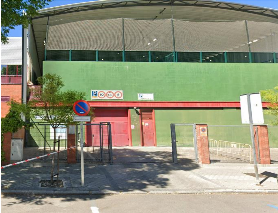
Ilustración 48 - Acceso rodado al Centro Deportivo Municipal Pradillo
