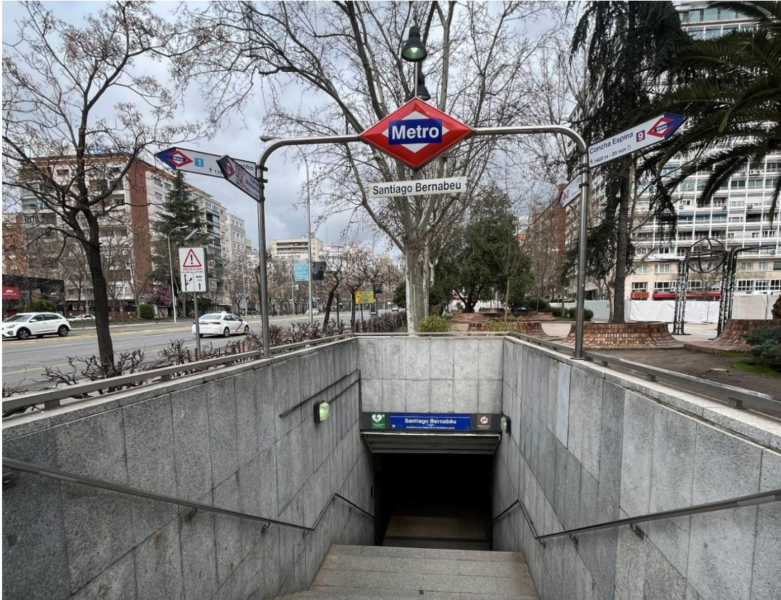
Ilustración 26 - Acceso a la Estación de Metro Santiago Bernabéu
