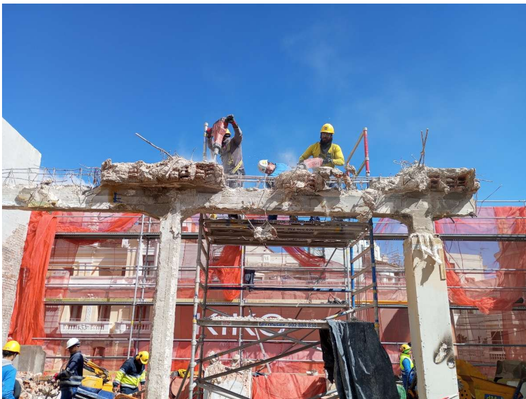
Ilustración 39 - Demolición y extracción de armaduras en Gran Vía 3 (INTEMAC)
