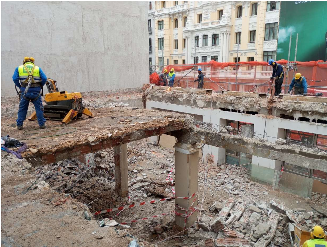
Ilustración 40 - Demolición y extracción de armaduras en Gran Vía 3 (INTEMAC)
