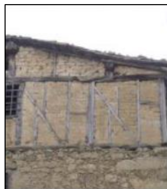
Entramado con relleno de adobe (Salamanca).
