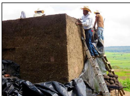
Figura 15. Ejemplo de una construcción de tierra empleando la técnica COB. (b.) Una casa de Inglaterra construida con COB.
