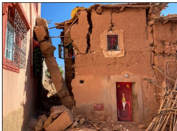
Figura 38. Una vivienda de adobe dañada por el terremoto de Marruecos en 2023.
