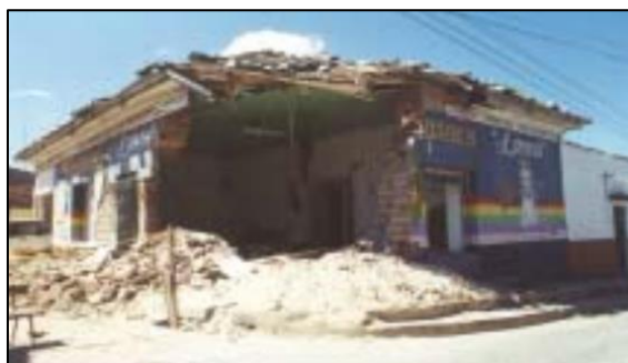
Figura 37. Colapso total de muros de adobe. Terremoto en El Salvador en febrero del 2001.
