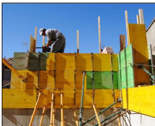
Figura 28. (a.) Elementos estructurales horizontales de madera que conforman la cubierta. (b.) Encofrado de madera del Tapial y la colocación de refuerzos verticales de madera y metálicos en los muros.
