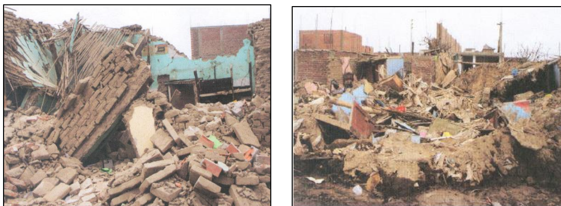
Figura 36. Colapso de una vivienda de adobe tras el terremoto de Pisco, Perú en 2007.
