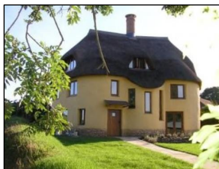
Figura 15. Ejemplo de una construcción de tierra empleando la técnica COB. (b.) Una casa de Inglaterra construida con COB.
