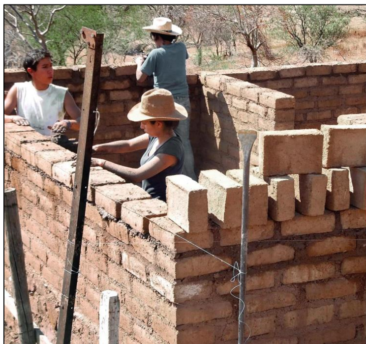
Figura 16. Ejemplo de construcción de viviendas con Bloques de Tierra Comprimita (BTC). Fuente: Arquitectura Viva (Maldonado, 2013).
