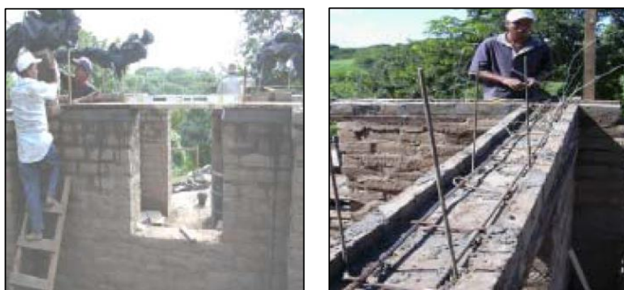
Figura 56. Construcción de una viga de coronación o collar de hormigón armado sobre un muro de mampostería de adobe de una vivienda en El Salvador (2002).
