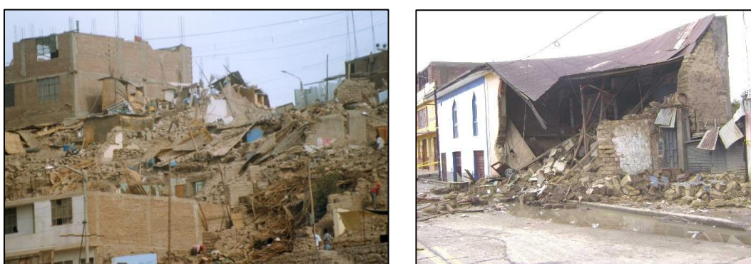
Figura 46. Viviendas elaboradas de adobe colapsadas por el terremoto en Arequipa en junio de 2001.
