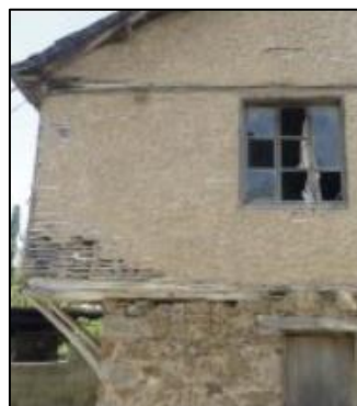
Entramado con listones de madera y tierra (León).
