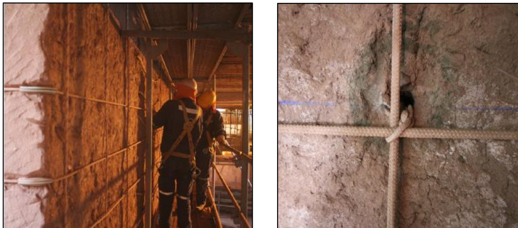
Figura 48. Enmallado de sogas sintéticas de los muros de adobe, intersección y anclajes de las sogas. Fuente: Revista Loggia: Arquitectura y Restauración, Núm. 30 (2017).
