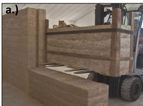
Figura 21. (a.) Montacargas para manipulación de bloques prefabricados de gran formato. (b.) Grúa especializada para manipulación de bloques prefabricados de mediano – pequeño formato.
