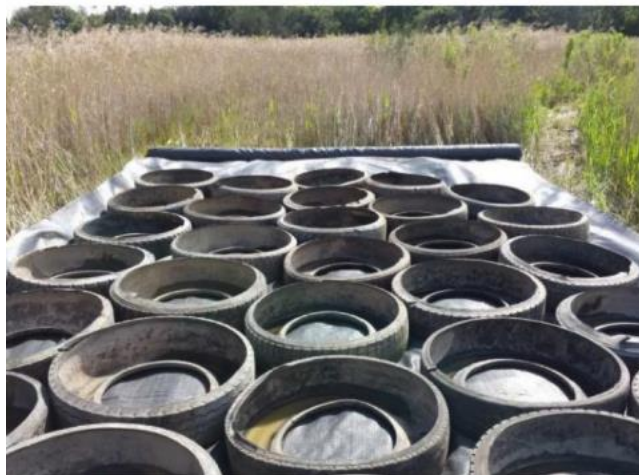
Imagen 15. Celdas de neumáticos listas para ser llenadas con el material de relleno granular. (Indraratna et al., 2022)
