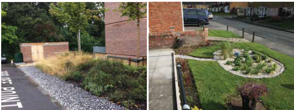
Figura 5. Zanja de infiltración (izquierda) y pozo de infiltración (derecha) (Fuente: 19, p. 304 y 336).
