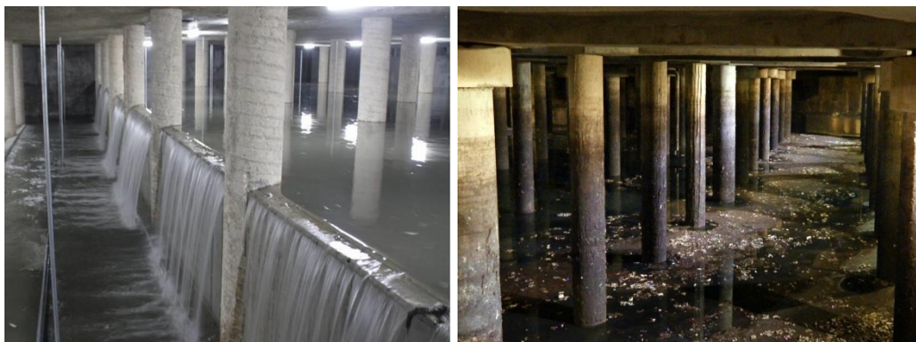
Figura 11. Ejemplos de tanques de tormenta existentes en Madrid (izquierda) y Alicante (derecha) (Fuente: Manual de recomendaciones para el diseño de tanques de tormenta 23 , p. 19 y 32).
