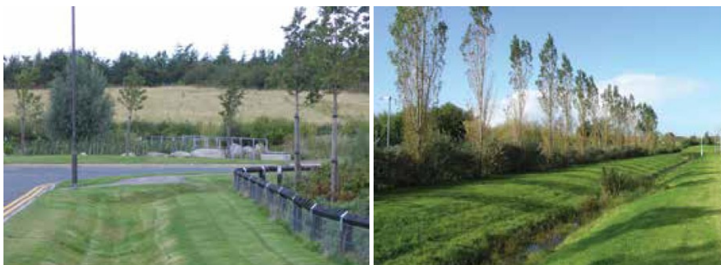
Figura 8. Ejemplos de cunetas verdes (Fuente: 19, p. 315).
