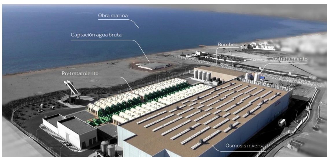
Ilustración 24. Desaladora de agua de mar del Campo de Dalías, Almería
