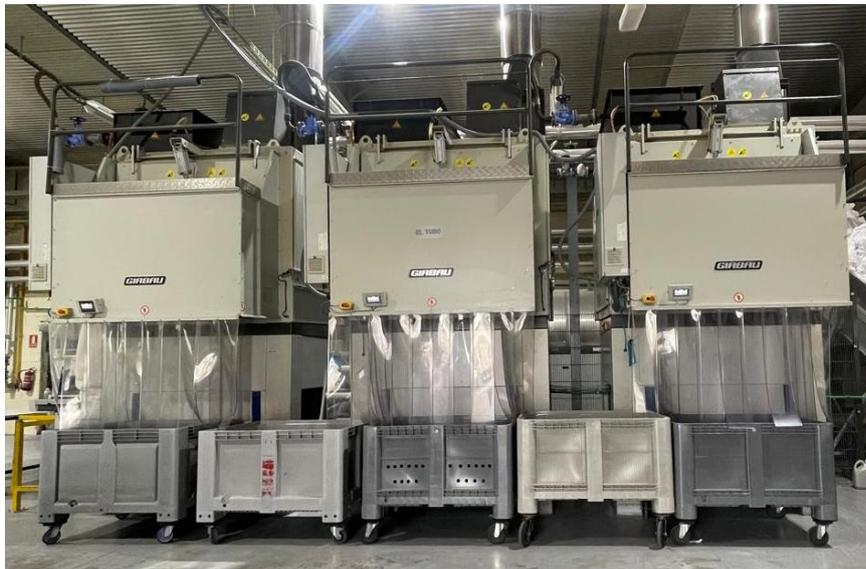
Nota: Vista frontal de las secadoras industriales ST-100 que forman parte del sistema continuo de lavado. Elaboración propia, 2025.
