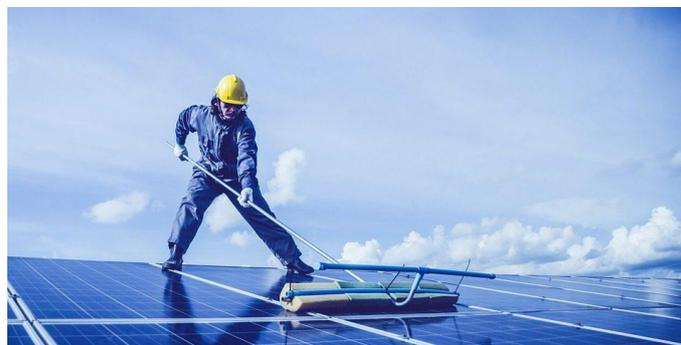
*Ilustración 31: Operario limpiando paneles solares (Fuente: Limpiezas Sil)*
