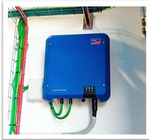
*Ilustración 4: Inversor solar en instalación de autoconsumo (Fuente: Ogre Renovables)*
