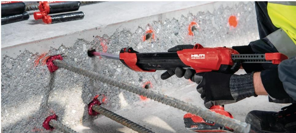
*Ilustración 26. Anclaje con epoxi - Hilti*
