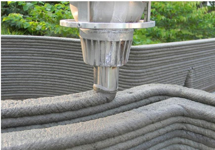
*Ilustración 1. Impresión 3D por capas - [www.hormisa.com.ar](http://www.hormisa.com.ar)*
