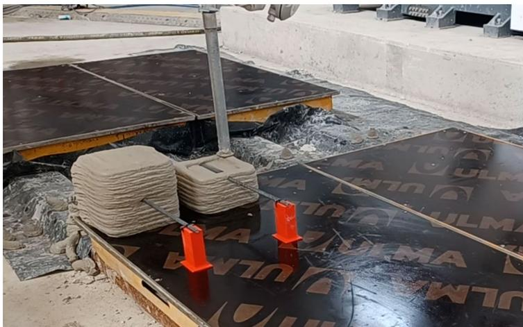
*Ilustración 33. Fase 2 de hormigonado de probetas*
