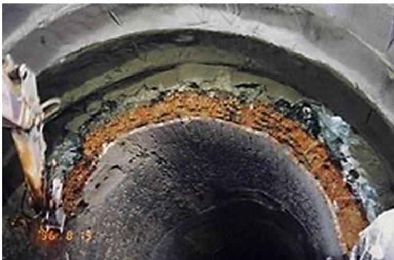
*Ilustración 80. Ampliación de túnel con demolición de revestimiento y aplicación posterior de sostenimiento. (ADIF, 2023a)*
