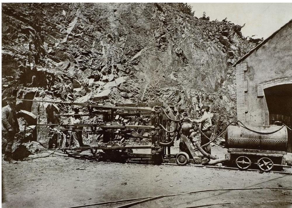
*Ilustración 3. Carro soporte de la perforadora Ferroux usada en la Argentera. (Maristany & Gibert, Eduard, 1891)*
