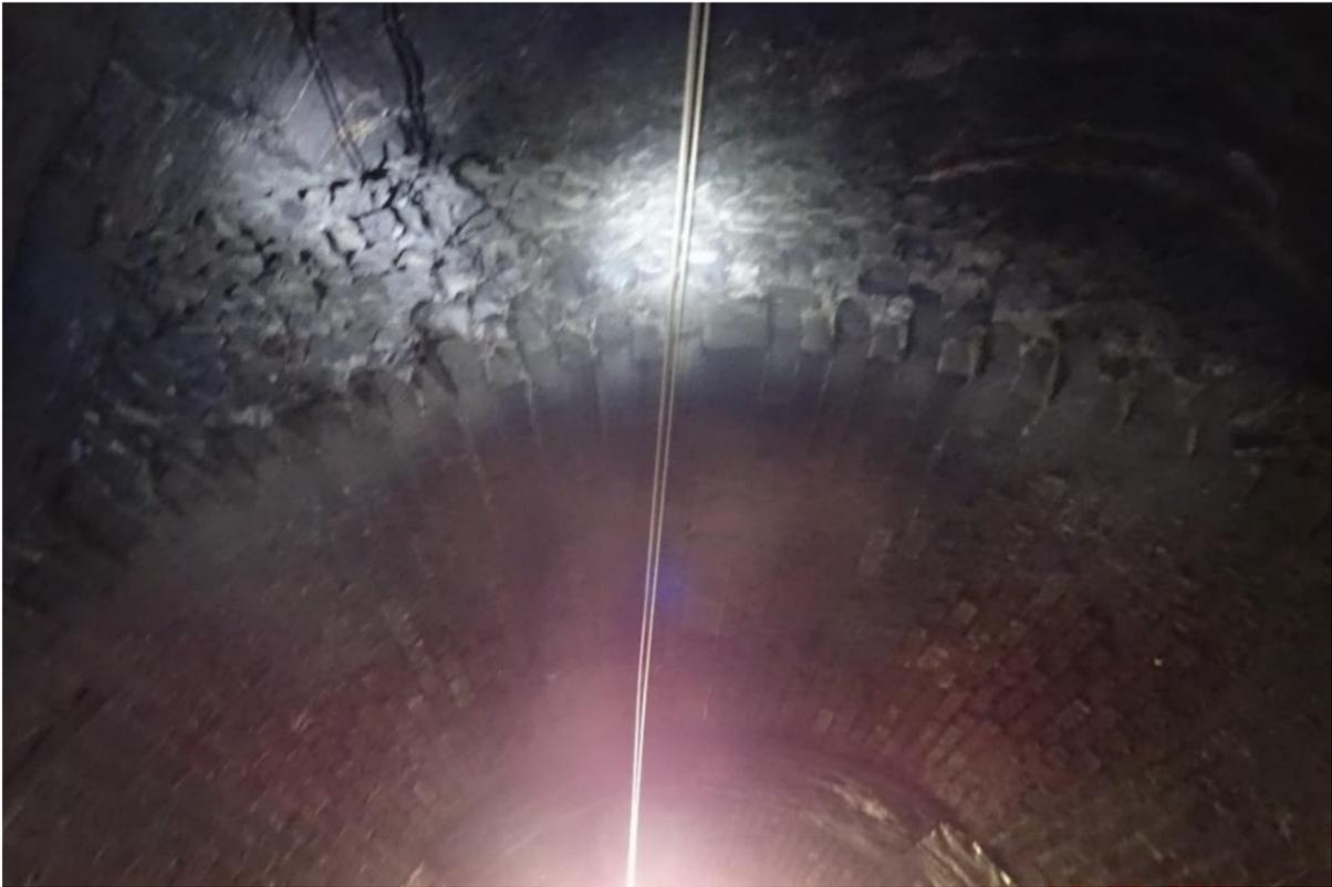
*Ilustración 5. Hueco del trasdós relleno con "piedra seca" (Túnel de Cárdenas). (ADIF, 2023a)*
