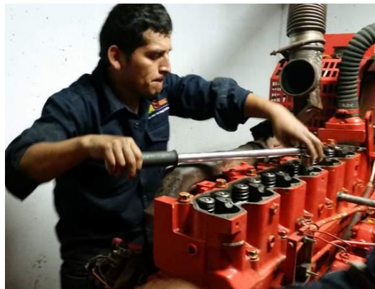
Ilustración 93 Operario realizando un mantenimiento correctivo debido a un fallo en el motor del GEL [140]
