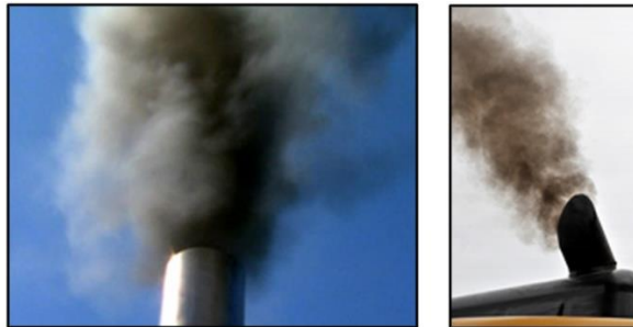
Ilustración 44 Humo negro del escape de un GEL que sufre de apilamiento húmedo [135]
