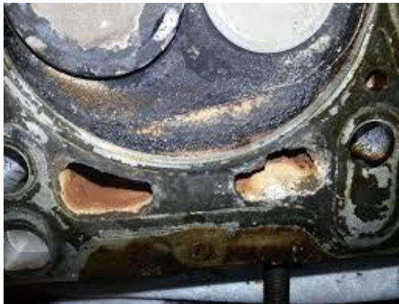
Ilustración 68 Culata y conductos internos del motor con presencia de corrosión [112]
