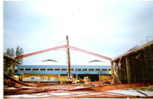
Ilustración 12 Colapso estructura por pandeo lateral-torsional.
