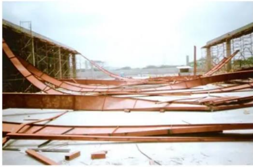
Ilustración 12 Colapso estructura por pandeo lateral-torsional.
