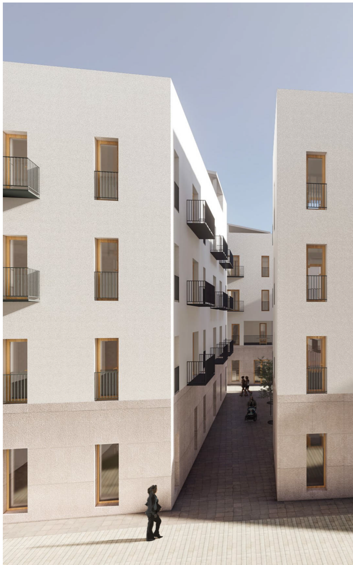
Acceso desde calle Conde de Moncofar
